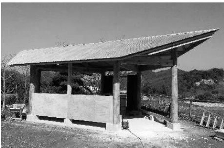
▲陶芸窯・ピザ石窯・燻製設備工事中の小屋
