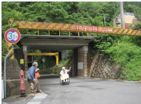
▲思い出深い実家近くの高架橋
