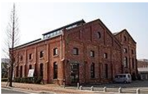
▲旧鐘紡洲本工場原綿倉庫跡
