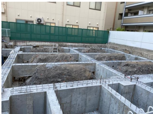
▲5月29日基礎工事
