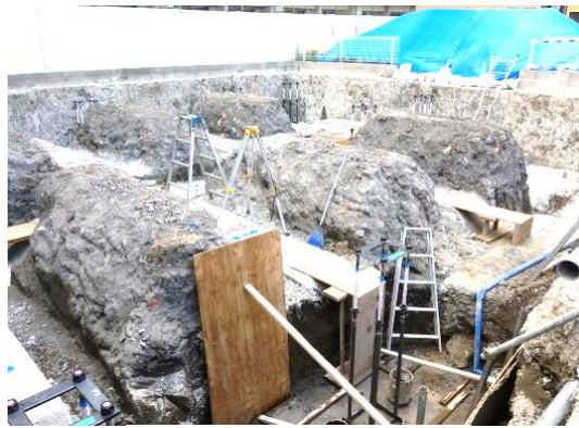
▲5月7日掘削工事
